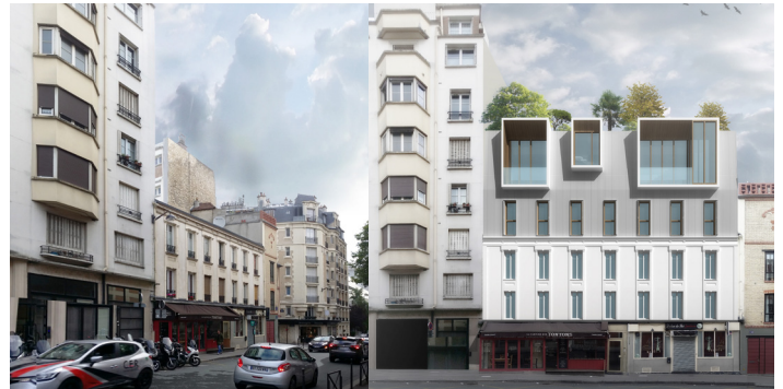
Surélévation d'un immeuble à Paris dans le 15 e arrondissement. Avant à gauche et après travaux sur la photo de droite.
